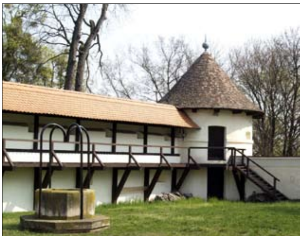
A helyreállított gyilokjáró
